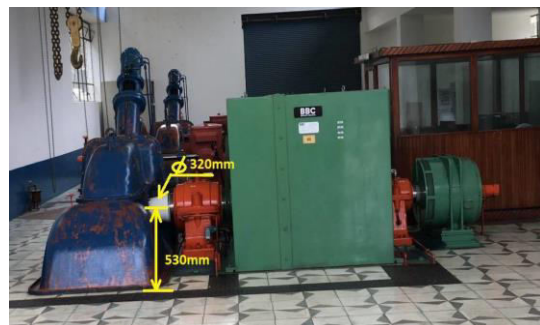
Figura 2: Dimensiones con respecto al eje de medición
