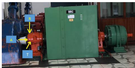
Figura 4: Ubicación del punto de medición en los ejes axial (A), radial (R) y transversal (T)
