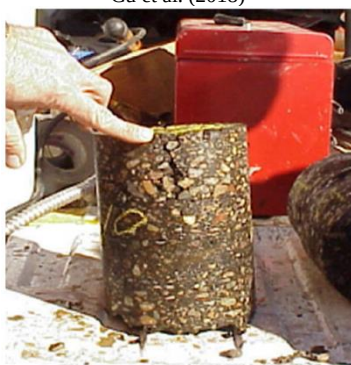
Figura 3. Testigo de pavimento existente con grieta típica TDC presentado por Harmelink et al. (2008)
