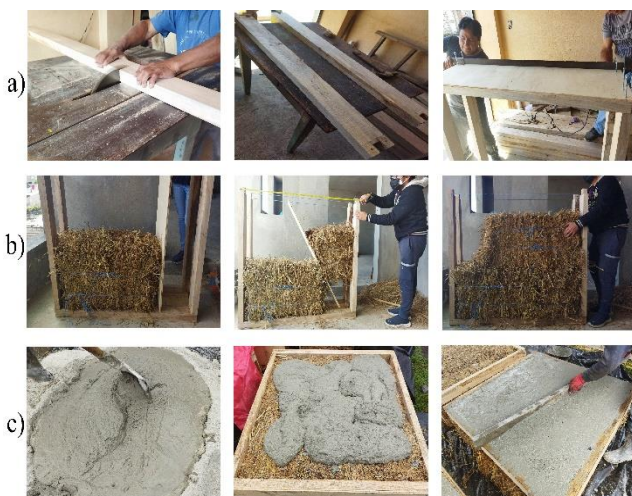
Figura 2. Proceso constructivo de paneles: a) ensamblaje de molduras, b) colocación de pacas, c) vertido del mortero de revestimiento
