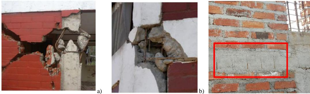
**Figura 4.** Fallas por mal detallado del refuerzo: a) Falla por cortante y pandeo del refuerzo longitudinal debido a separación de estribos excesiva en los extremos de la columna de confinamiento; b) falla por discontinuidad de refuerzo longitudinal (Tomado de Brzev et al., 2010), y c) exposición del refuerzo debido a recubrimiento inadecuado en una edificación en Cuenca.
