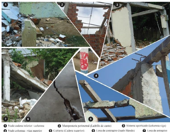
Figura 2. Estado físico de las edificaciones en el momento de la evaluación. Fuente el autor.
