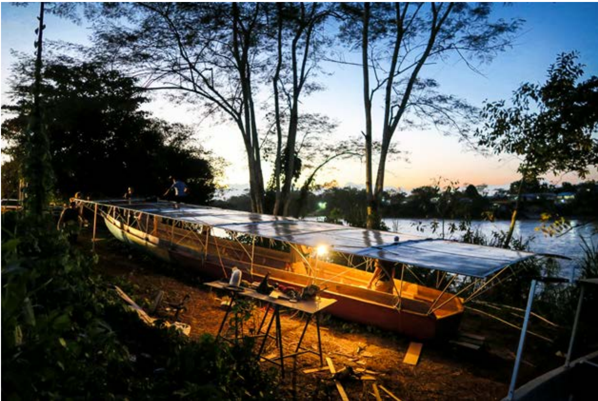
Figura 5. Construcción de 'Tapiatpia'. Fotografía Martina Avilés, Kara Solar. Sucumbios, 2016.
