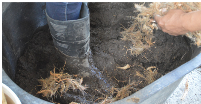
Foto 6.- Mezcla de la tierra húmeda (chocoto) con la fibra de coco, fuente: Ing. Freddy Paredes Avilés.
