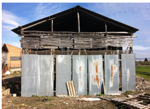
Figura 14: Transformaciones en la envolvente efímera de los secaderos de piel vegetal. Cúllar Vega. Granada.
