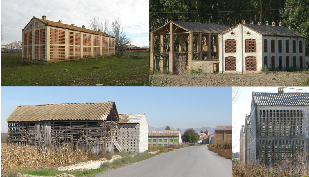
Figura 9: Composición: Materialidad. Prototipos de ladrillo, madera de chopo y hormigón. Fuente: Propia. 2015.
