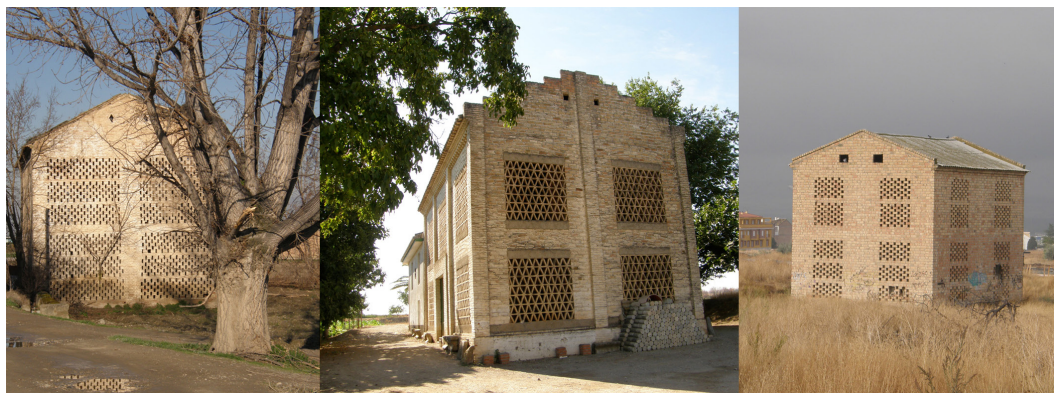
Figura 11: Contundencia formal en la diversidad de la técnica constructiva. Camino de Chauchina-Romilla. Margen Sur del río Genil. Granada. Fuente: Propia. 2014-2015.
