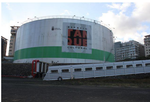
Figura 2: El Espacio Cultural “El Tanque” (exterior)
